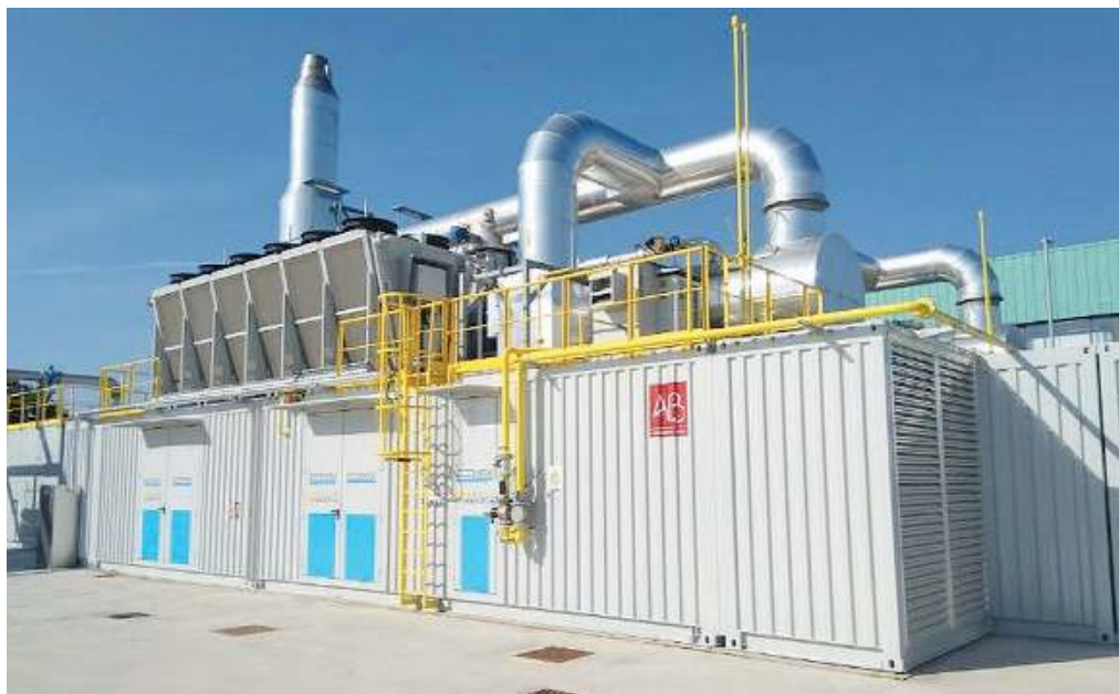
Cogenerazione. Uno degli impianti realizzati dal gruppo bresciano AB, con quartier generale a Orzinuovi
