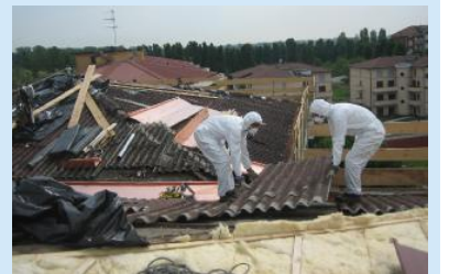
Addetti impegnati nella bonifica dall'amianto
