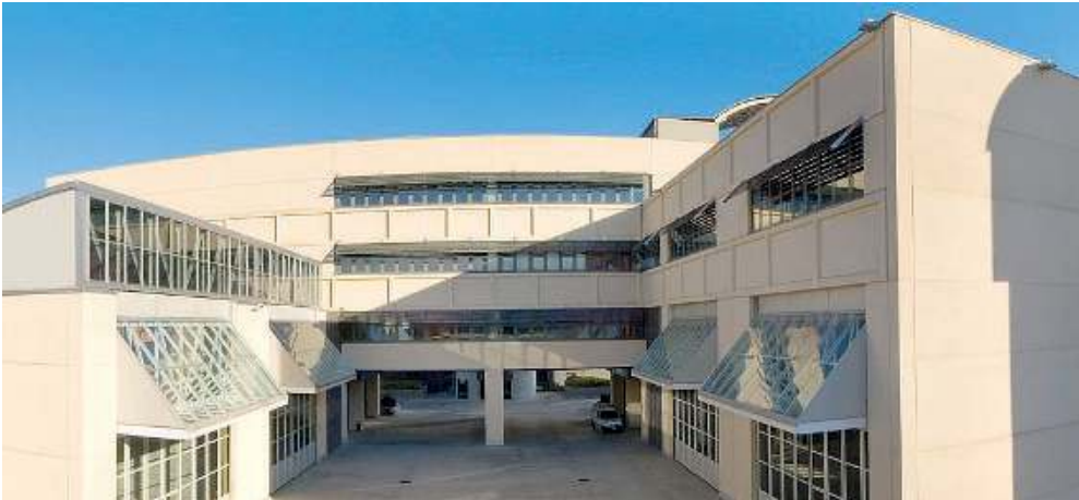
Csmt. La sede dell'Innovation Hub in via Branze
