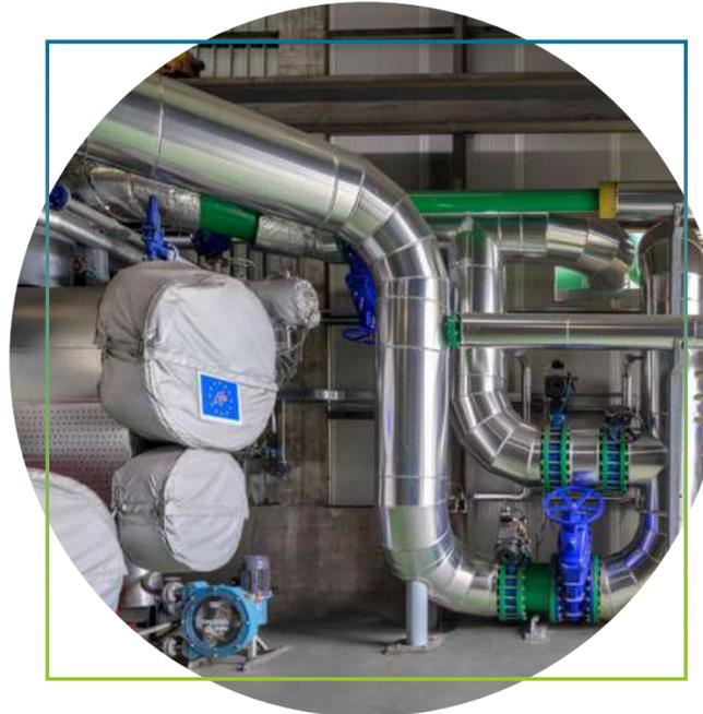
Grazie a una speciale pompa di calore di grandi dimensioni, il calore viene recuperato a bassa temperatura (circa 70°C), portato a una temperatura adeguata (da 95°C a 120°) e immesso nella rete di teleriscaldamento comunale.
