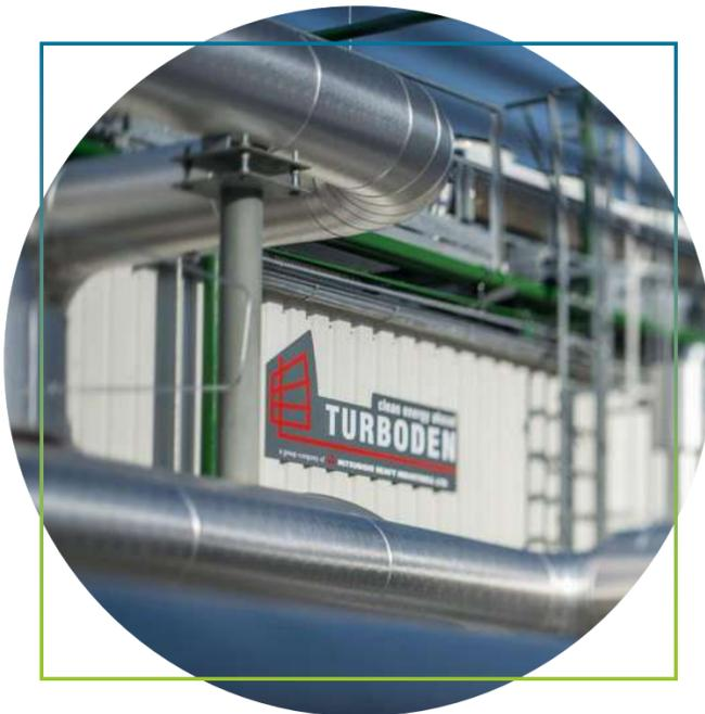
Impianto di recupero del calore residuo. Il calore viene immesso nella rete di teleriscaldamento di Brescia o convertito in energia elettrica..
